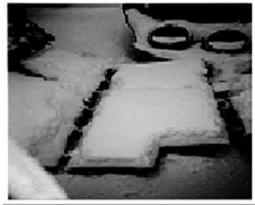
**Рис. 4. Разделанная на фрагменты заданных размеров торцевая часть кормового отсека прочного корпуса ПЛ пр.641**
